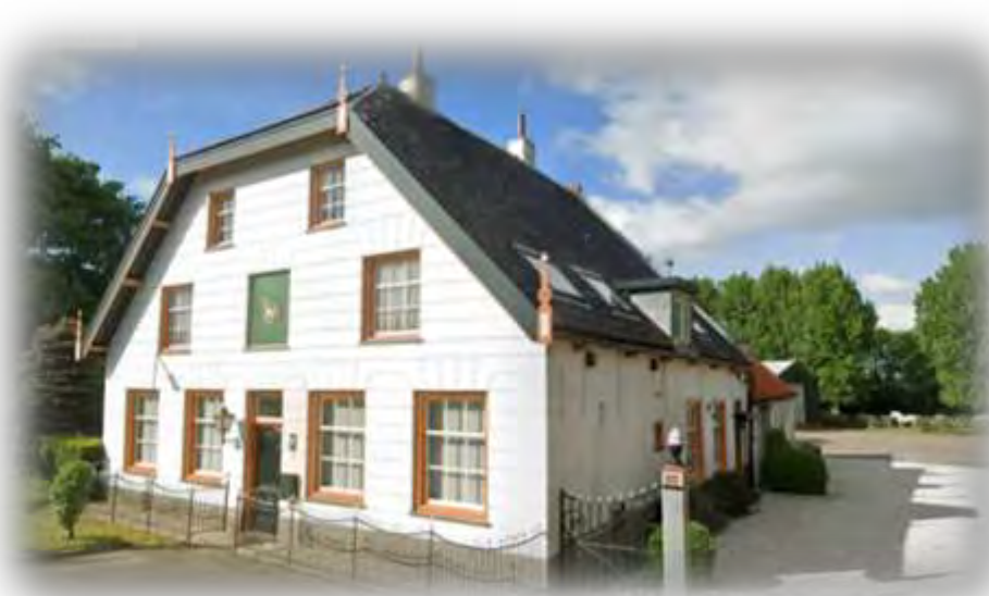
Monumentaal woonhuis "Dijkzicht" aan de Keizersdijk, met (net zichtbaar) het achterhuis...
