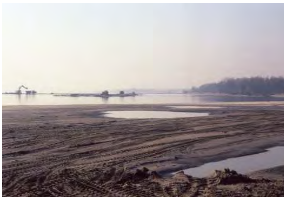
Na 30 jaar kwam het tot aanleg van een oeververdediging. Rechts de voormalige Hoogezandsche eendenkooi. Foto: Gerard Ouweneel
