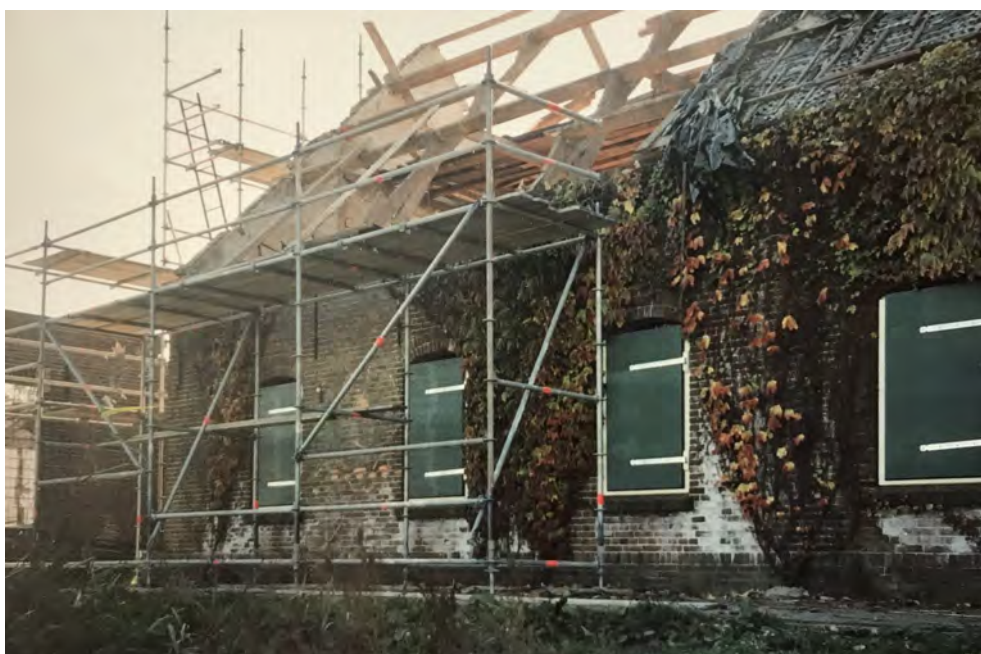
Klein Profijt in de steigers voor vernieuwing van het dak.
